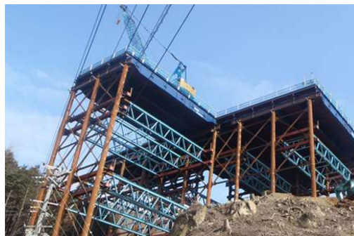
工事用仮栈橋(Hi-BRIDGE 工法®)
