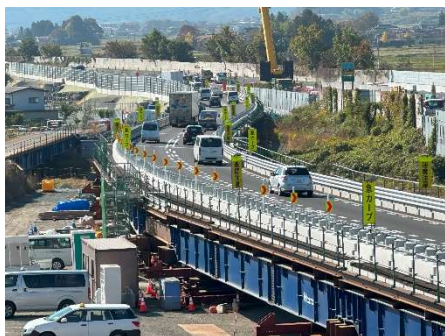
高速道路の迂回路仮橋(プレガーダーⅢ)
