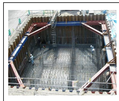
<施工事例>大分市公共下水道 弁天水資源再生センター水処理施設増設工事
