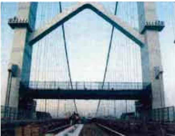
路面防護工にプレガーダー橋を採用（大鳴門橋）
