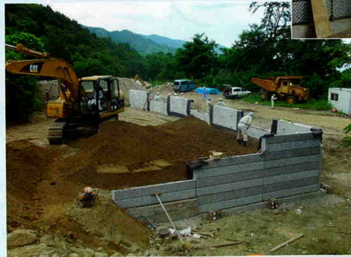
8月半ば、山梨県内で始まった試験施工の現場。大判のコンクリートスキンが2段目まで据え付けられ、盛り土作業が始まっている
