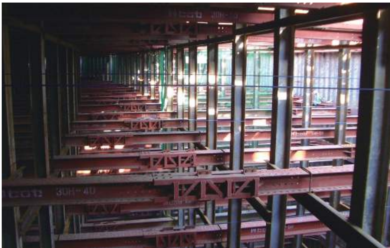
■ 水平切梁工法
