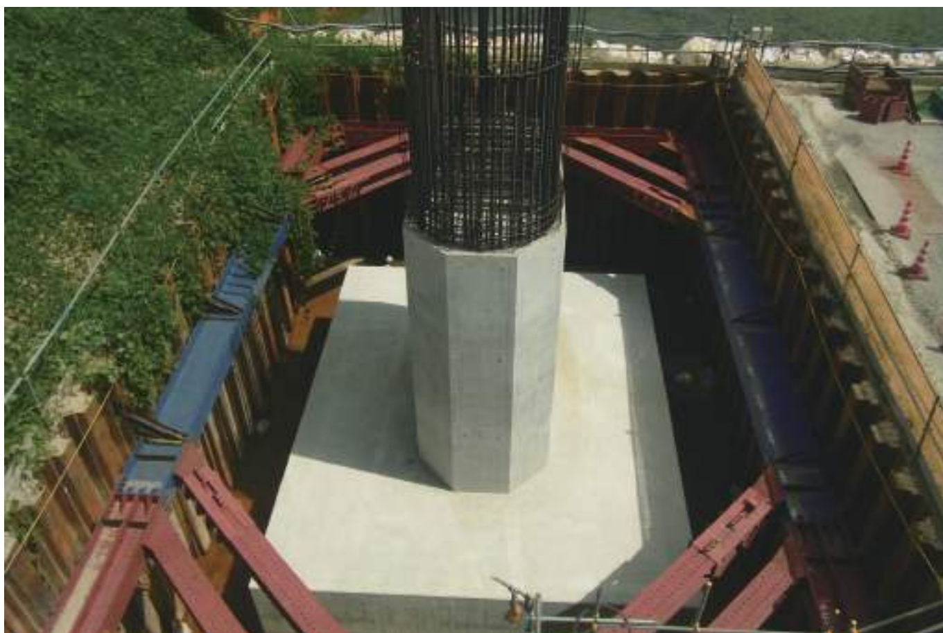
ヒロセメガビーム®(高強度腹起)工法
