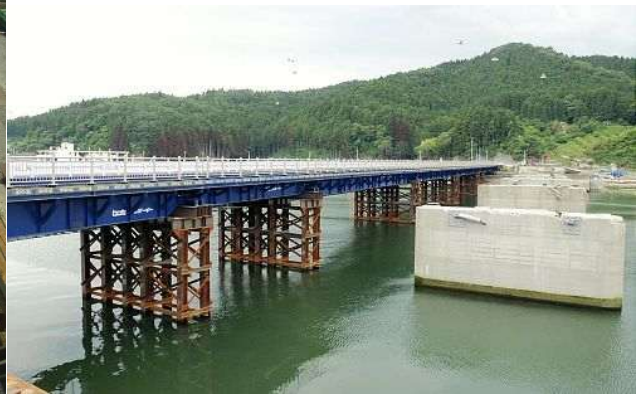
仮設橋梁による災害対応事例
