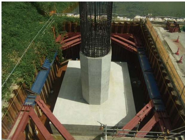
重仮設による山留工事の様子
