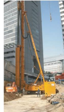
削孔状況(鋼材は削孔時の定規材)
