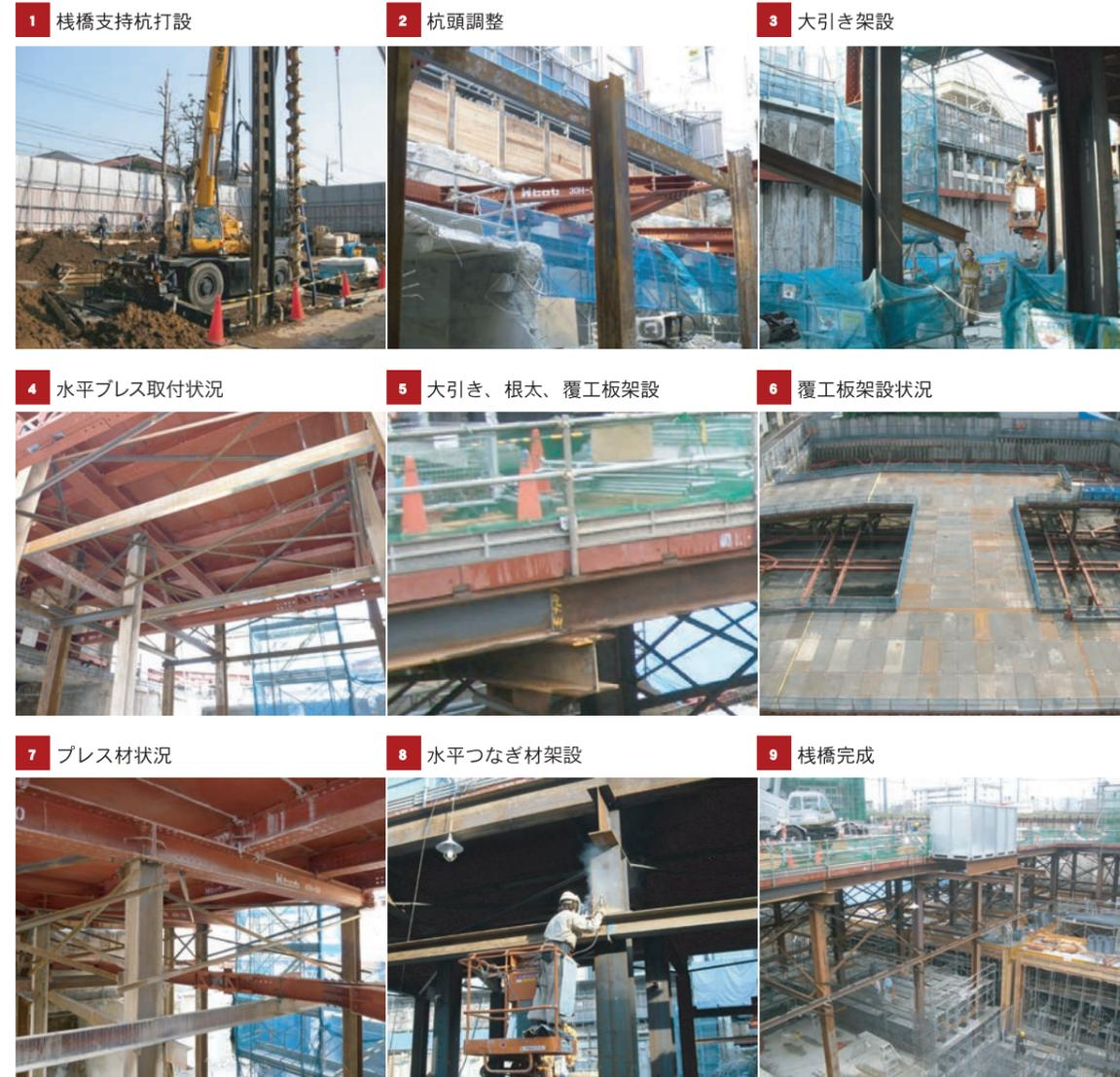
作業空間の確保：根切り、山留の架設、本体地下部分の施工、鉄骨建方、山留の解体まで作業構台（ステージ）は必要不可欠。いかに重機の作業性が良く、小さな面積で納めるかが腕の見せ所です。
