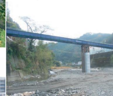
上：プレガーダー橋 桁長22m×幅員6m
