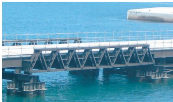
乗入れ部リフトアップ架台 桁長39m×幅員4m
