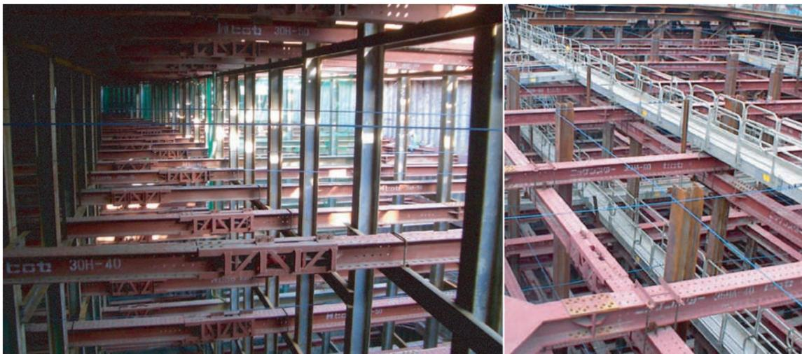
剛性の高い60°火打を用いた水平切梁工法
