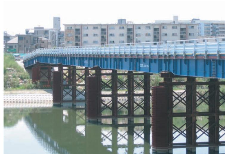
右：プレガーダー橋 桁長最長30m×幅員8~13.5m×7径間
