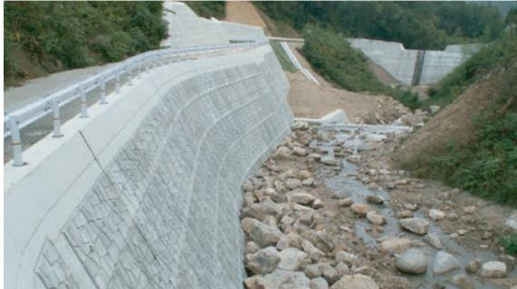
緑化配慮タイプ、魚類配慮タイプ併用天場にガードレール基礎使用 壁高6.3m
