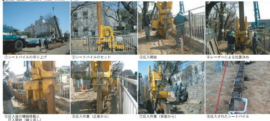
■地盤の固い場合：地盤の固い場合に使用するアースオーガー併用圧入工法もあります。
