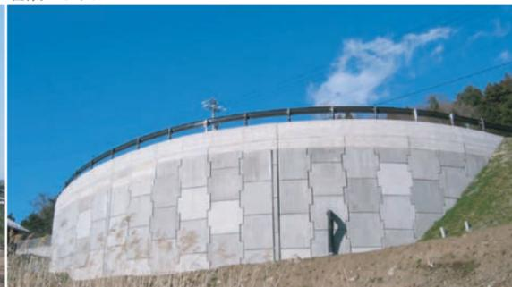
曲線施工を組み合わせた複合橋台
