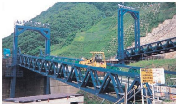
山岳急速施工栈橋(Hi-BRIDGE工法)
