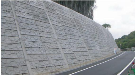
天端に落石防護柵付き 壁高3.9m
