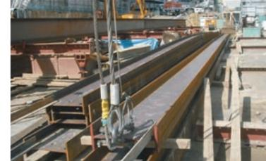
2 芯材の吊り上げ状況と芯材の建込み定規
