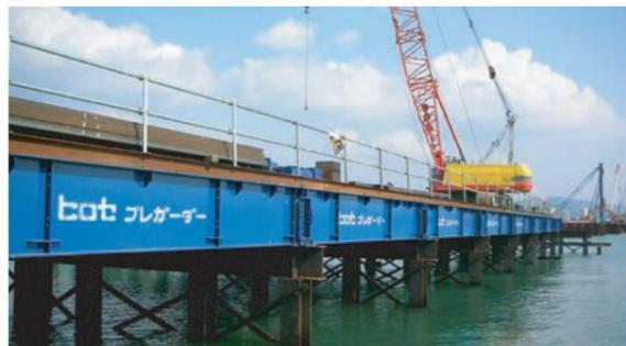
工事用仮橋 桁長24m×幅員8m
