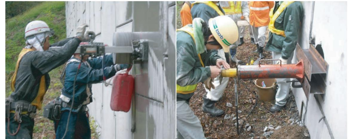
壁面材の補修：補強土擁壁は貴重な社会資本であり永久構造物です。初期の安定性はもちろん、長期にわたる維持・補修が必要です。テールアルメは「補強土（テールアルメ）壁工法設計・施工マニュアル」（土木研究センター）においてパネルの部分補修の方法が公的に認証されている唯一の補強土工法です。メンテナンスは容易であり、かつ安全に行うことができます。
