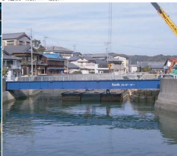
歩道橋 桁長32m×幅員1.5m
