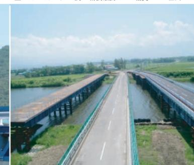
プレガーダー橋 桁長 28m+24m×幅員2.5m
