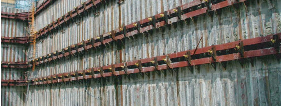
火打ブロックを使用した、安定感のある水平切梁工法
