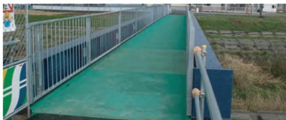
跨線橋 桁長24m×幅員2.1m
