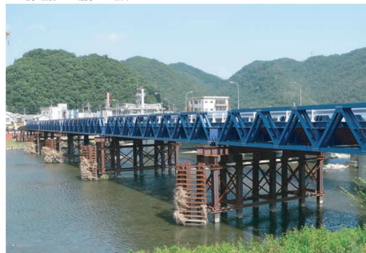
プレガーダー橋 桁長24m×幅員6m×8径間
